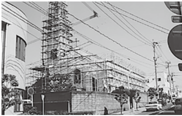
改修工事中の福江教会
